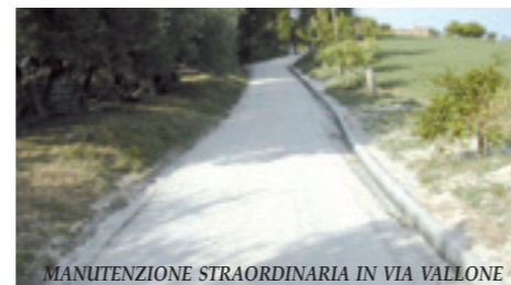
MANUTENZIONE STRAORDINARIA IN VIA VALLONE
